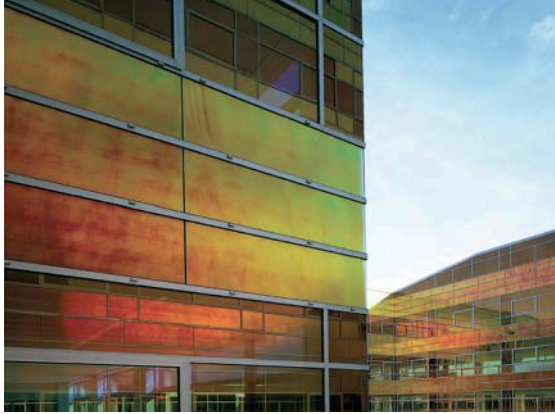
Cette construction ménage les oiseaux en raison du verre fortement coloré et peu réfléchissant ainsi que par l'absence d'angles transparents sur le bâtiment.
