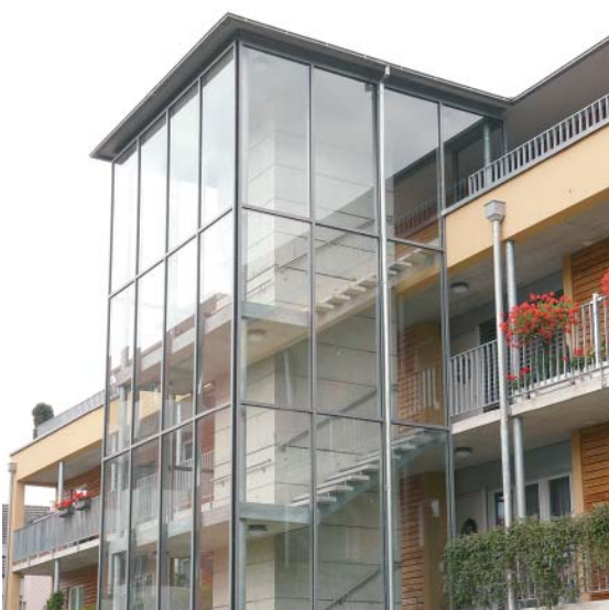
Cage d'escalier en verre
