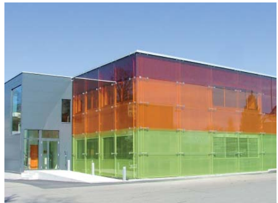
Poste de police innovateur : quasi pas de zones problématiques pour les oiseaux.
