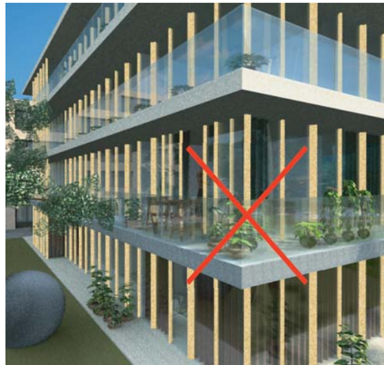
Les plantes en pot ne doivent pas être placées directement derrière la fenêtre, mais plus à l'intérieur du bâtiment. La végétation luxuriante dans le jardin d'hiver représente également un danger.
