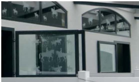
Dans l'élaboration de ce décor original d'un manège, la règle de la paume d'une main n'a malheureusement pas été entièrement respectée.
