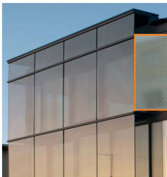
Un fin tissu inséré entre les plaques de verre réduit les réflexions à l'extérieur, agit contre l'éblouissement à l'intérieur, mais permet quand même la vision vers l'extérieur (surface intérieure du tissu noire).
