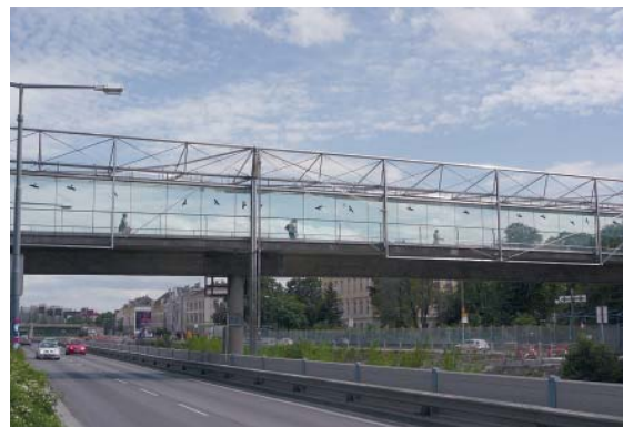
Passerelle pour piétons en verre
